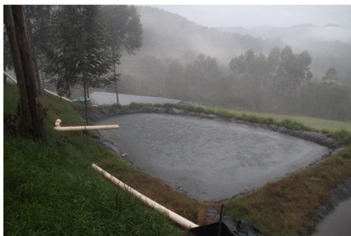
Esterqueira instalada na propriedade de Jacir Fávero.
